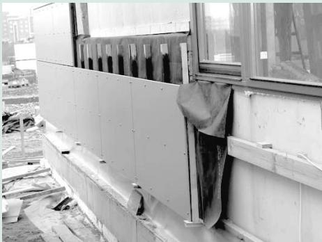
**B<sub>2</sub>) несущая решётка из системных профилей на базе алюминия, оцинкованного железа**
